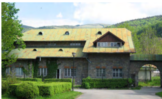
Staționarul ecologic Posada
