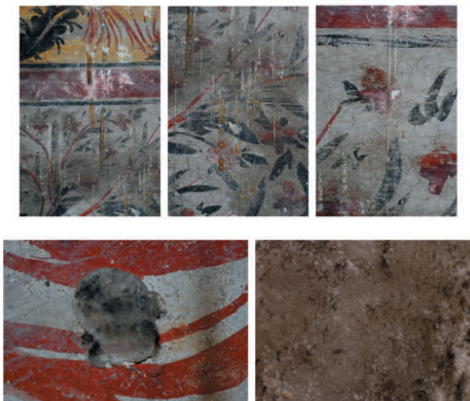
Fig. 7 - Fig. 11. Depuneri de ceară în diferite stadii de descompunere (biserica din Ionești, naos)
