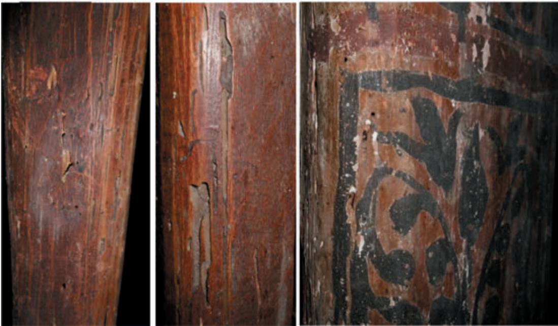
Fig. 14 - Fig. 16. Galerii ale insectelor xilofage dispuse în plan orizontal și vertical (biserica din Amărăști, naos)
