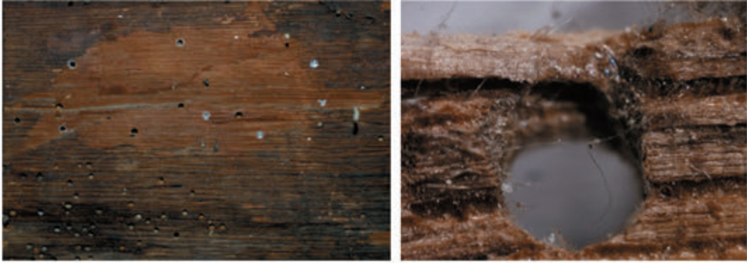
Fig. 12 și Fig. 13. Orificii de zbor ale insectelor xilofage colonizate de fungi microscopici (biserica din Ionești, naos)
