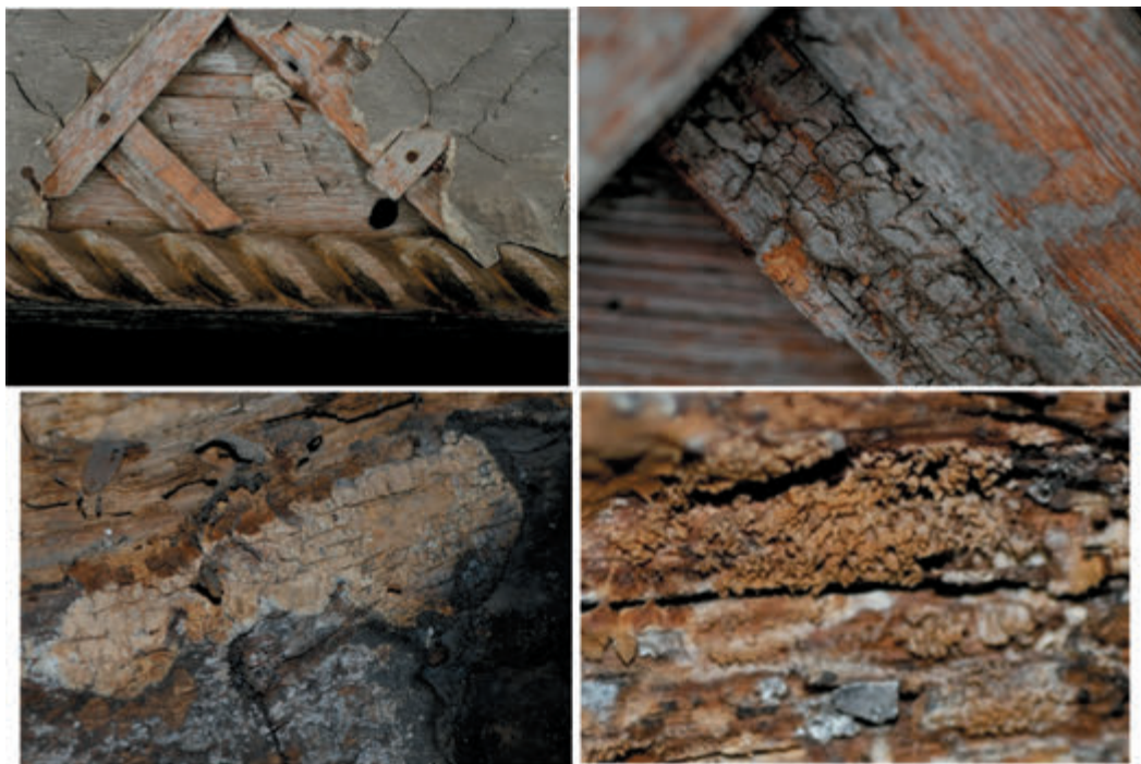
Fig. 3 – Fig. 6. Lemn colonizat de bazidiomicete: miceliu, corpuri de fructificație (biserica din Amărăști, pridvor și pronaos)
