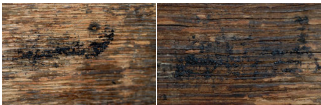
Fig.1 și Fig. 2. Lemn colonizat de fungi filamentoși (biserica din Ionești, naos, interior)
